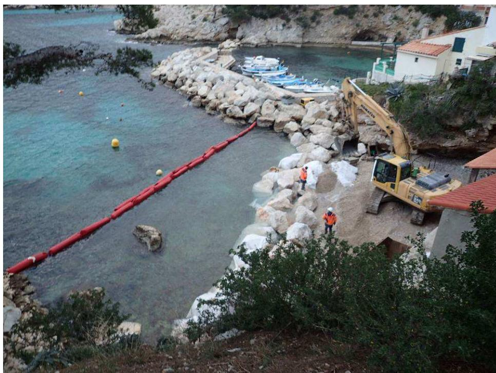
Figure 3 Mise en place d'un cordon de protection contre la houle et d'un dispositif limitant à la source l'émission de matière en suspension
